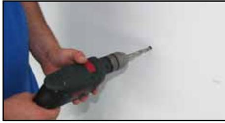
3. Отверстия для крепления к стене и подключения воды-теплоносителя (используйте монт. шаблон – см. таблицу)
