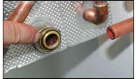
7. ... в канавке фланца клапана подачи
