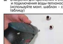
Отверстия для крепления к стене и подключения воды-теплоносителя (используйте монт. шаблон - см.
