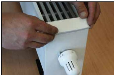
14. Закрепите кожух фиксирующими винтами
