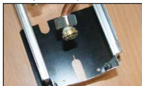
4. выход из арматуры подачи воды-теплоносителя
