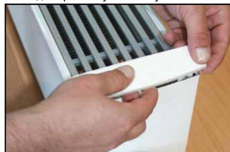
13. Закрепите кожух фиксирующими винтами
