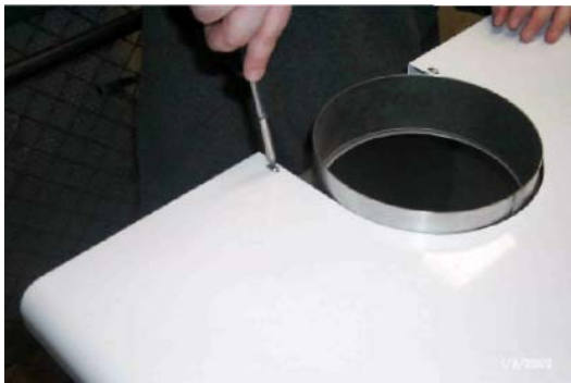
Рис. 3 – Отвинтите 2 самонарезных винта, удерживающих крышку котла.
