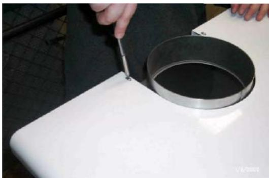
Рис. 3 – Отвинтите 2 самонарезных винта, удерживающих крышку котла.
