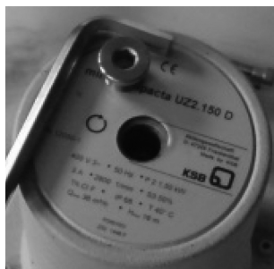
Рис. 14: Направление вращения насоса
