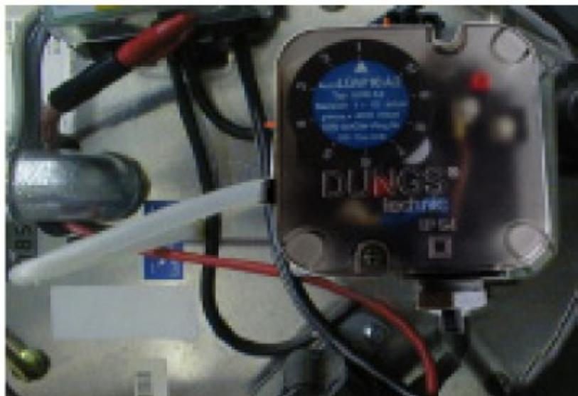
При вводе в эксплуатацию газовой горелки компании "Giersch" на датчике давления воздуха LGW 10A2 необходимо установить следующие значения:
