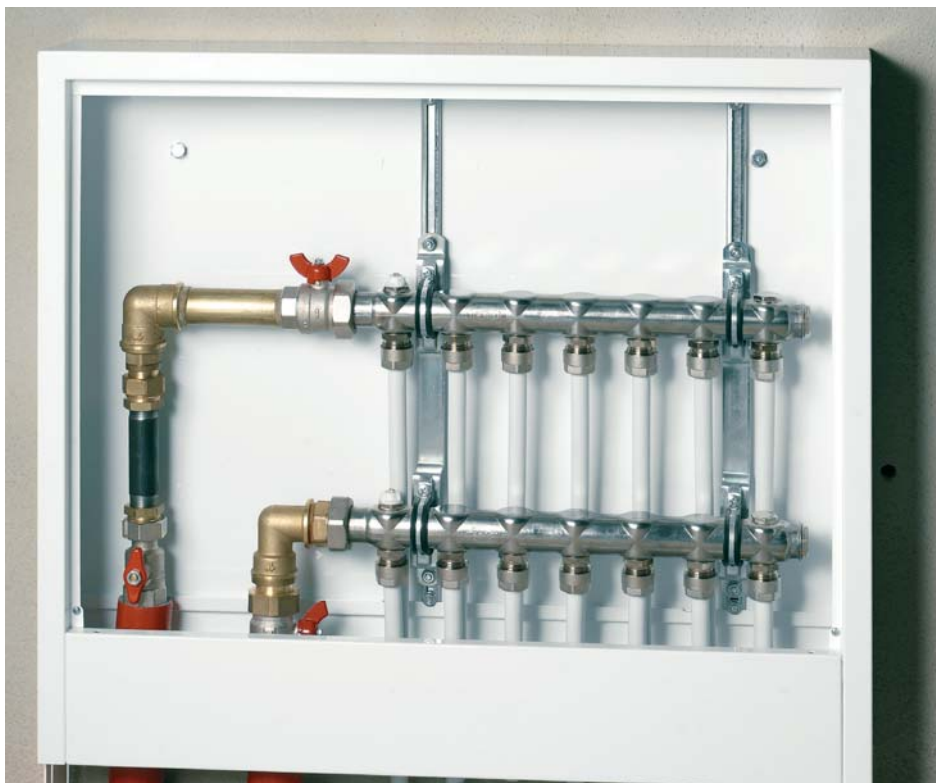
Открытый монтаж распределителя в шкафу xnet
