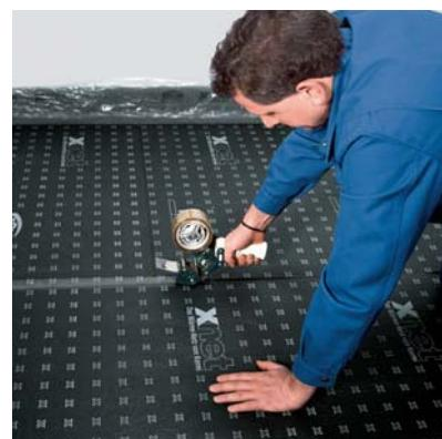
В заключение проклеить участки наложения и стыки. Таким образом можно быстро выкладывать даже большие площади, обеспечивая герметичное уплотнение против влаги, содержащейся в бесшовном полу.
