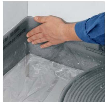
Установить боковые изоляционные полосы вдоль стен по всему периметру, снять клейкую защитную ленту, прижать – и готово!
