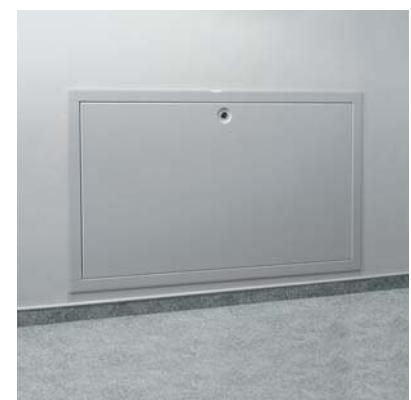
Готовый черновой монтаж. Экран бесшовного пола обеспечивает звукоизоляционный монтаж, а строительная защитная крышка – чистоту внутри шкафа.
