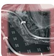
**Боковая изоляционная полоса** системы xnet предназначена для выполнения боковых стыков и обеспечивает деформационный зазор не менее 5 мм согласно стандарту DIN 18560. Ее необходимо без пропусков наносить на все возвышающиеся строительные детали. При наличии дополнительной звукоизоляции боковая изоляционная полоса перед укладкой прошивной плиты системы xnet C12 plan или прошивного рулонса системы xnet C12 roll накладывается на эту дополнительную звукоизоляцию.
