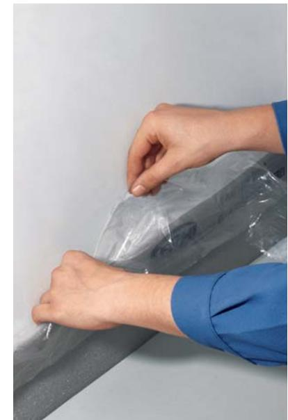
Сверхдлинную полосу из полиэтиленовой пленки просто наложить сверху для свободного наложения плит.
