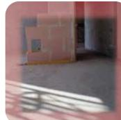
Эта основа должна быть достаточно сухой для монтажа слоя распределения нагрузки и иметь ровную поверхность. На ней не должно быть точечных возвышений, трубопроводов и т.п., которые могут привести к созданию шумовых перемычек и/или к перепадам в толщине бесшовного пола.
