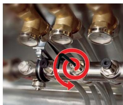
Повернуть шпиндель вентиля вверх на расчетное значение, например, на 2,0 оборота.
