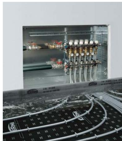
Шина для изменения направления труб обеспечивает точную подгонку при переходе труб к расположенной поверхности и точную посадку экрана бесшовного пола.
