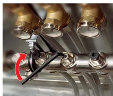
Шестигранным ключом на 6 мм вывернуть юстировочный винт вниз до шпинделя вентиля. Таким образом, эта настройка сохраняется, даже если в дальнейшем вентиль будет перекрыт.
