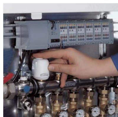
... закрепить сервопривод с помощью защелок. Подключенный кабель вставить в направляющий паз модульного узла управления.
