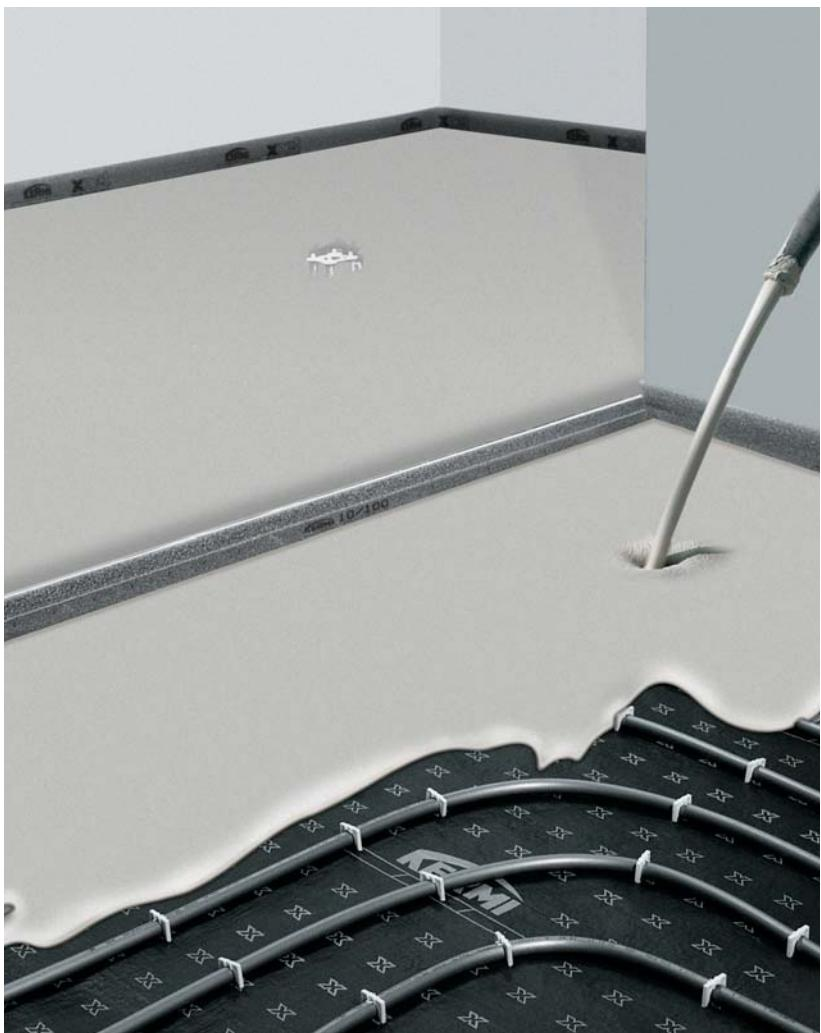
**Сначала бесшовный пол наносится на полосу пленки с края. Затем вся площадь заливается до нужного уровня по высоте и выравнивается.**
