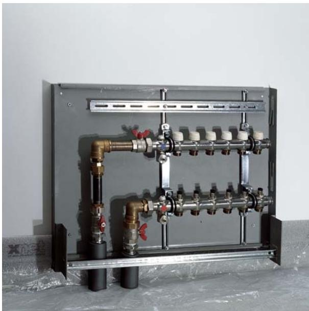
Заднюю стенку распределительного шкафа в открытом исполнении (поверх штукатурки) установить на верхней кромке чистового пола, прикрепить дюбелями к стене. Распределитель поставить на шины и подключить.
