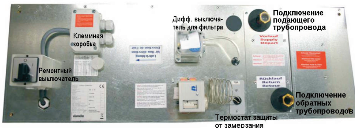
Монтажные позиции комплектующих вентблока Airblock FG
