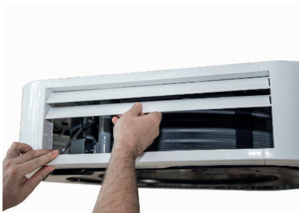
Рис. 31: Снятие ламелей
