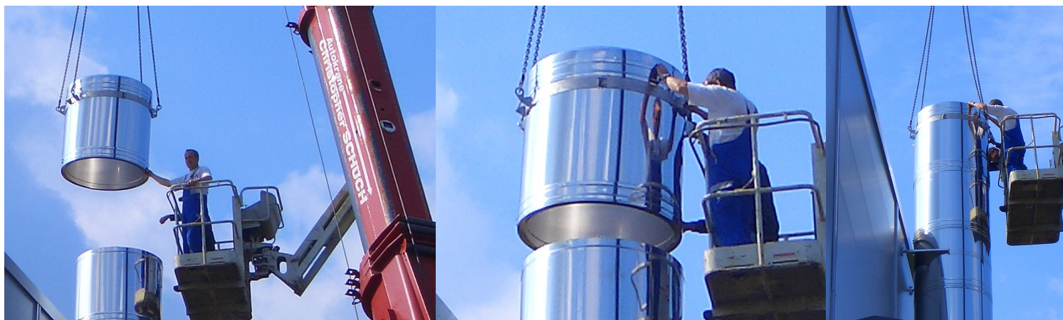
Рис. 18 Пример монтажа при помощи приспособления
