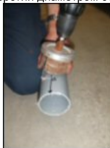
5. Наклоните сверло от себя и рассверлите отверстие с другой стороны.
