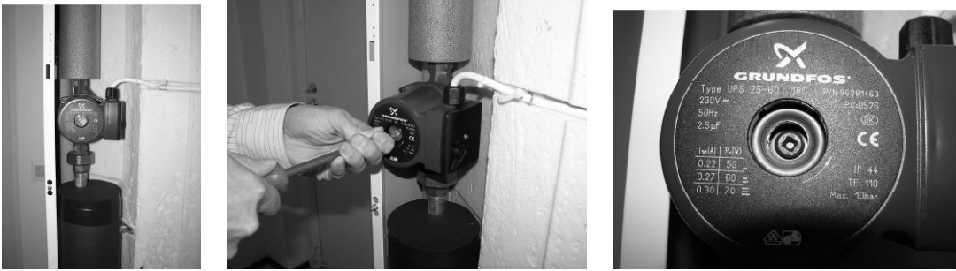
Рисунок 2. Включение циркуляционного насоса.
