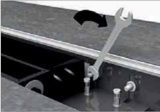
L 60: закрепление внутреннего канала
