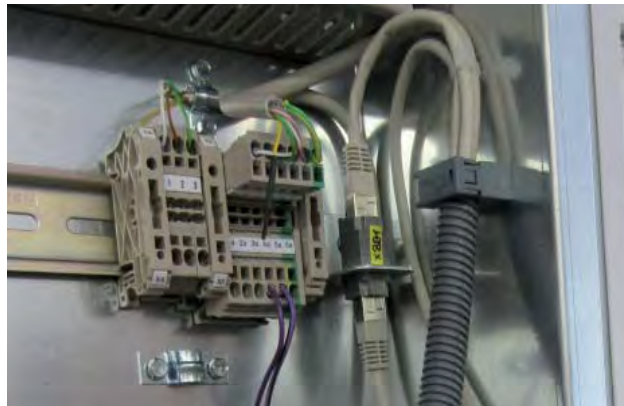
LAN-кабель можна помістити у кабельний канал
