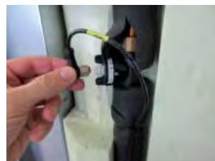
Реле протоку B2
