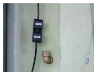
Роз'єм для 3-х ходового клапану
