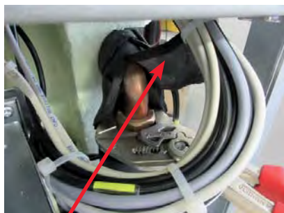
Ізоляція Armaflex
