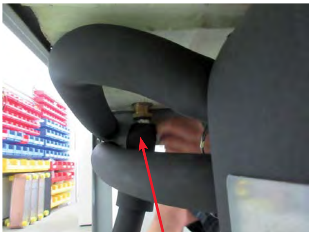
Ізоляція Armaflex
