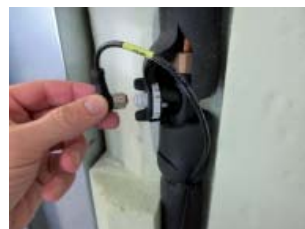
Реле протоку B2
