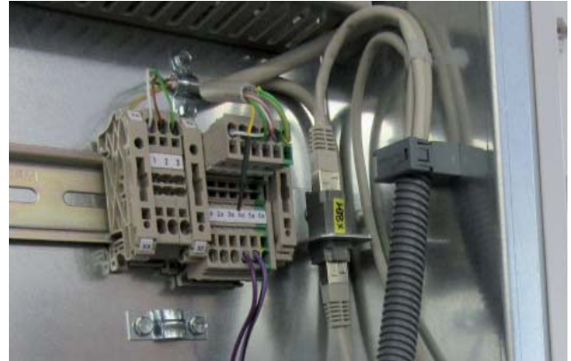
LAN-кабель можна помістити у кабельний канал
