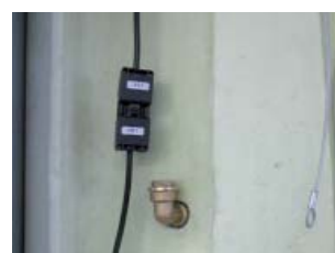
Роз'єм для 3-х ходового клапану
