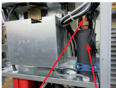
загальна труба подачі електронагрівач
