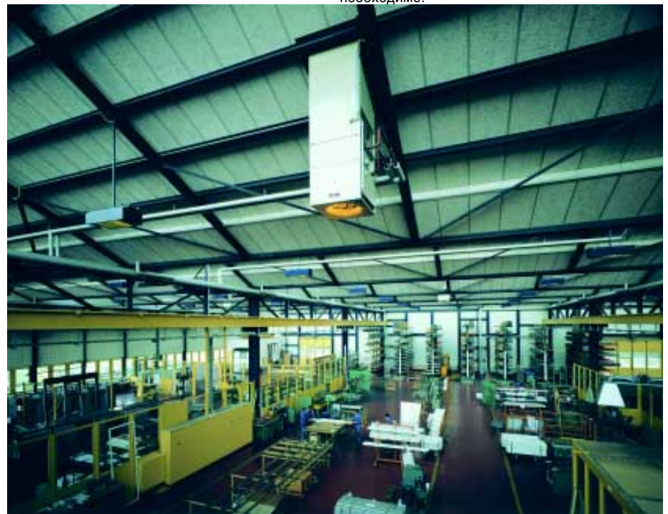
Блоки с подачей свежего воздуха монтируются на крыше, обеспечивая экономию полезной площади
