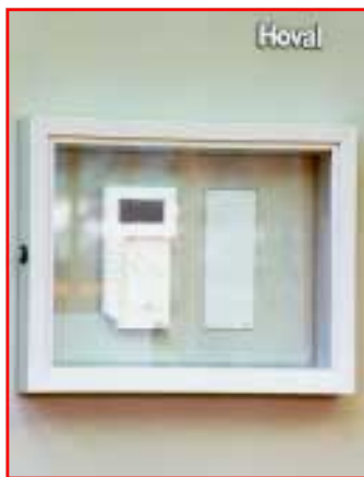
Рис. 25: Блок DigiMaster, установленный на панели зонального управления с защитным окошком
