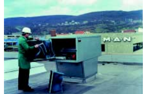
Приточно-вытяжной агрегат LHW легко обслуживается со стороны крыши
