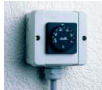
Рис. 7: Потенциометр PMS-W для управления клапанами смесительной секции
