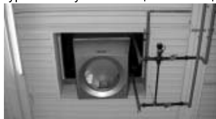
Рис.5. Агрегат TopVent® commercial с гидравлическим модулем
