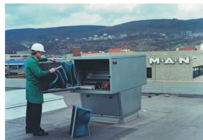
Приточно-вытяжной агрегат LHW легко обслуживается со стороны крыши
