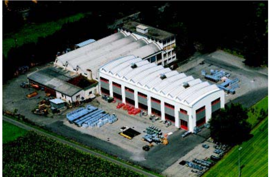
Завод в Лихтенштейне (Schaan)
