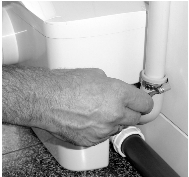
(Abb. 4) Zum Anschluß der Druckleitung befestigen Sie die DN 25-Druckleitung im Abgangsbogen, der sich oben rechts am Behälter befindet, mit einer Schelle. Verlegen Sie die Druckleitung stetig steigend (im Idealfall erst senkrecht, dann waagrecht) in einer Schleife über das Niveau der Rückstauenebene des öffentlichen Abwasserkanals. Dies verhindert, dass bei einem Ansteigen des Wasserspiegels im Abwasserkanal, z. B. bei starkem Regen, Abwasser durch die Druckleitung in den Behälter der Saniflux zurückgedrückt wird. Führen sie die Druckleitung von dort direkt bis zum nächsten Sammelabfluss. Überprüfen Sie nochmals alle Anschlüsse und Verbindungen auf ihre Dichtigkeit. Stecken Sie nun den Stecker in eine geerdete Steckdose, die Hebeanlage ist jetzt betriebsbereit.
