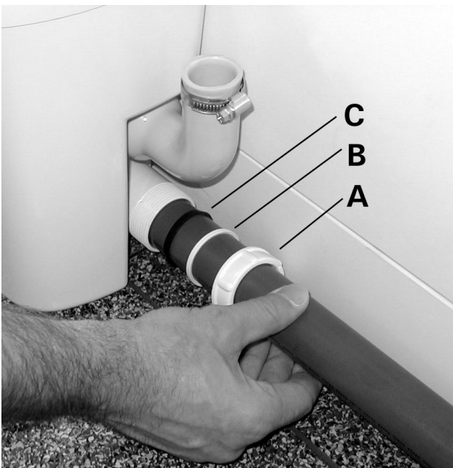
(Abb. 3) Stecken Sie nun die Überwurfmutter (Pos. A), den Druckring (Pos. B) und den schwarzen Keildichtring (Pos. C) wie Abgebildet auf die DN 40-Abflußleitung und schieben Sie diese bis zum Anschlag in die gewählte Zulauföffnung des Behälters. Befestigen Sie die Abflußleitung, indem Sie die Überwurfmutter am Zulaufstutzen festdrehen, dabei muss der schwarze Keil-Dichtring zwischen Überwurfmutter und Zulaufstutzen liegen. Verfahren Sie genauso, wenn sie weitere Sanitäranlagen anschließen möchten.
