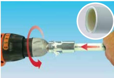
Использовать инструмент HENCO kalispeed для центровки трубы и снятия заусенцев с внутреннего и внешнего краев трубы.
