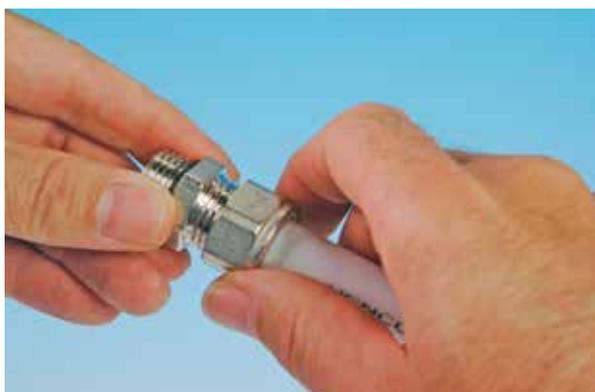
Теперь навернуть накидную гайку или соответствующий кран, коллектор или соединительную трубную муфту. Всегда делать это с помощью двух раздвижных гаечных ключей и прилагать рекомендованные производителем усилия или усилия, указанные в следующей таблице.
