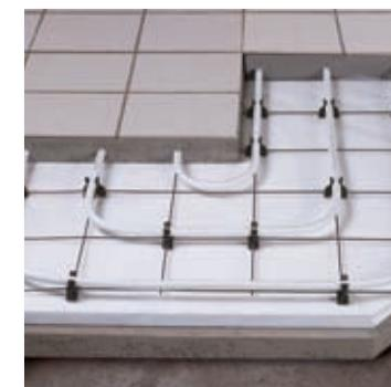
**Стальная сетка:** теплоизоляция размещается под сеткой. На теплоизоляцию кладется полиэтиленовая пленка, а на нее стальная сетка. На сетку устанавливаются клипсы для трубы. Сверху заливается бетон с пластификатором.
