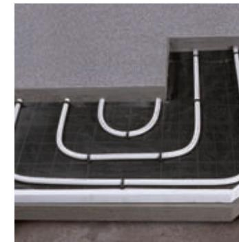
**Степлер:** теплоизоляция укладывается на пол. Сверху кладется полиэтиленовая пленка. С помощью степлера и специальных клипс труба закрепляется на изоляции. Сверху заливается бетон с пластификатором.
