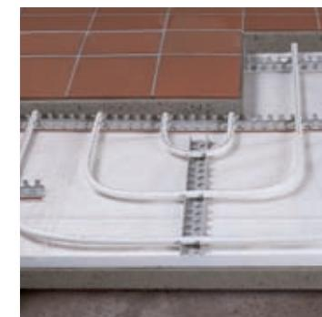
**U-профили:** теплоизоляция укладывается на пол. Сверху кладется полиэтиленовая пленка и устанавливаются U-профили. На профили устанавливаются трубы. Сверху заливается бетон с пластификатором.
