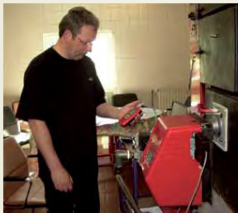
Рис.3 Монтаж и наладка параметров горелки
