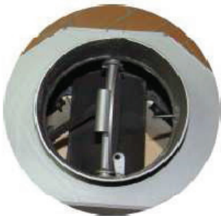
Рис.4.1. Положение заслонки при открытой двери
