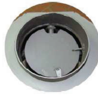
Рис.4.2. Положение заслонки при закрытой двери
