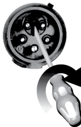
Рис. 30 Смена фаз трёхфазного шкафа управления с фазовым инвертером
