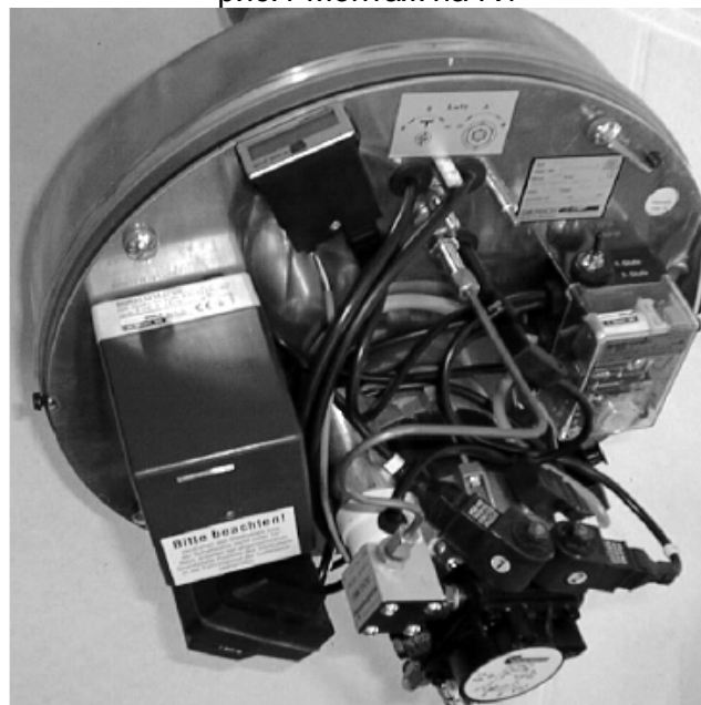
рис.2 Монтаж на R20
