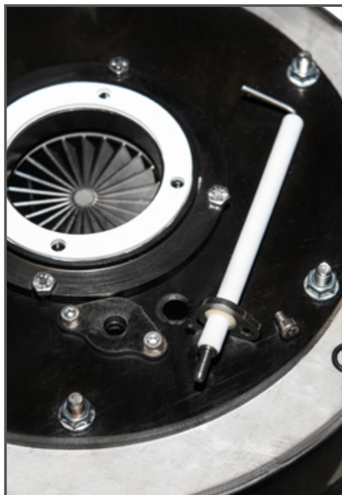
Электрод розжига и ионизации
