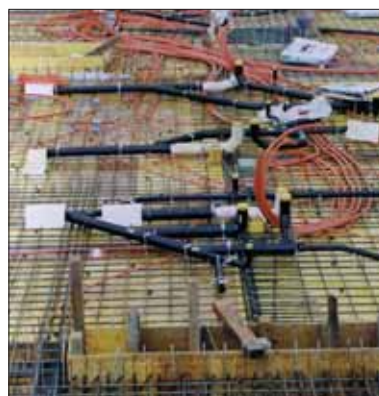
Трубопровод, заделываемый в бетон
