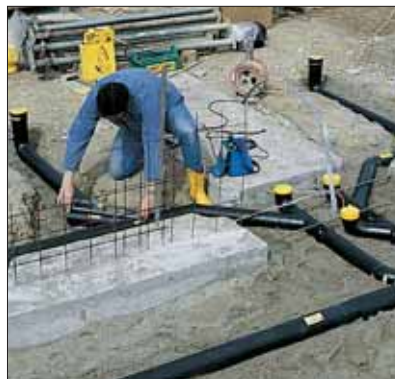
Предварительно собранные узлы сборки монтируются посредством электросварных муфт-стяжек.
