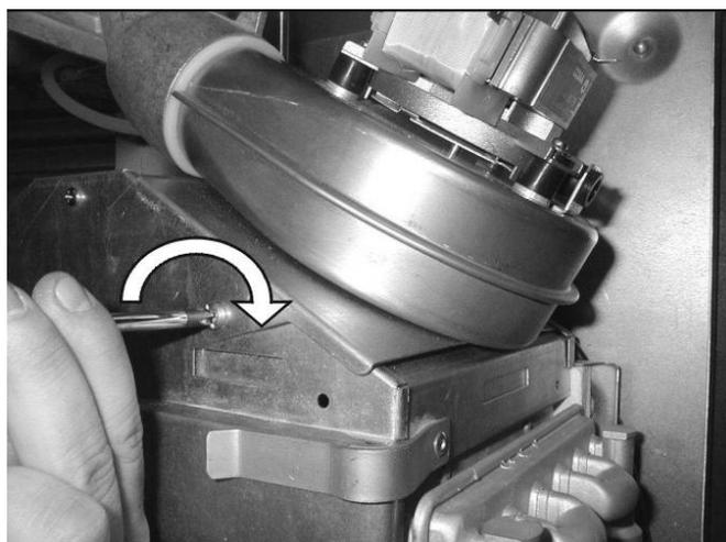
3. Повернуть вентилятор по часовой стрелке так, чтобы вынуть патрубок вентилятора из выпускного колена (см. рис. 54).
