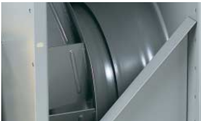
Перемычка на выхлопе вентилятора GTLB (“язык”)
