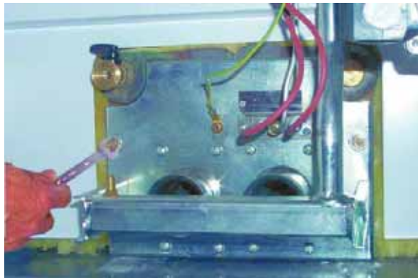
рис. 23 - Демонтаж горелок
