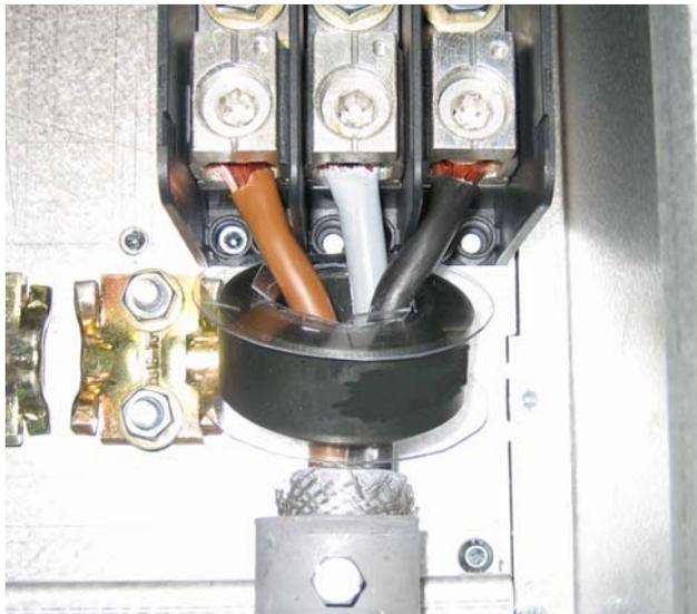
Рис. 49 Ферритовый сердечник установлен на кабелях двигателя
