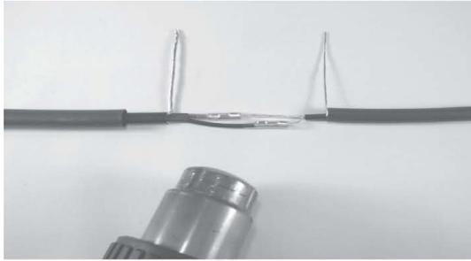
Надвиньте на место соединения прозрачную термоусаживаемую трубку KYNAR1/8", 25 мм, отцентрируйте ее и усадите ее при помощи термофена.
