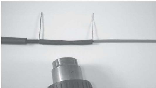
Поместите среднюю термоусаживаемую трубку 8/2, 75 мм поверх места соединения так, чтобы она перекрывала средний слой изоляции обеих кабелей. Усадите ее, начиная с середины и постепенно передвигаясь к концам.
