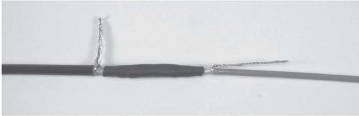
Надвиньте маленькую термоусаживаемую трубку 4/1, 35 мм поверх сделанного соединения, отцентрируйте ее относительно соединительной гильзы и усадите ее, начиная с середины и постепенно передвигаясь к концам.
