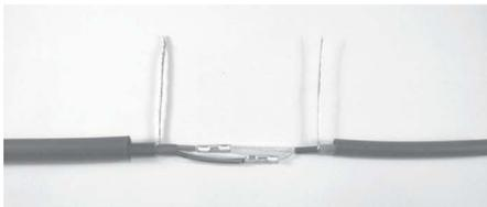
Укоротите среднюю термоусаживаемую трубку 8/2 до 75 мм и наденьте ее поверх кабеля DTIF/DTVФ.
