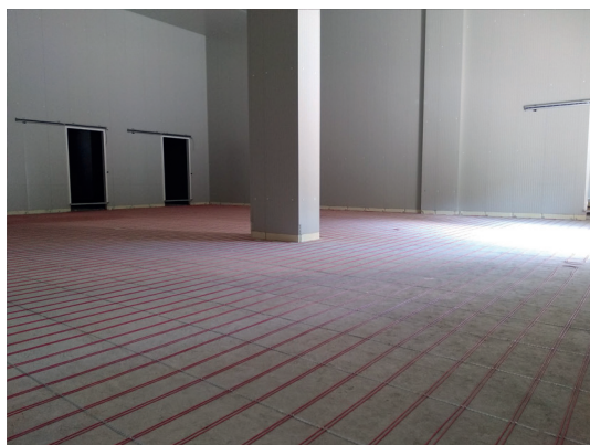
Фото 2. Монтаж системы защиты грунта холодильной камеры от промерзания.
