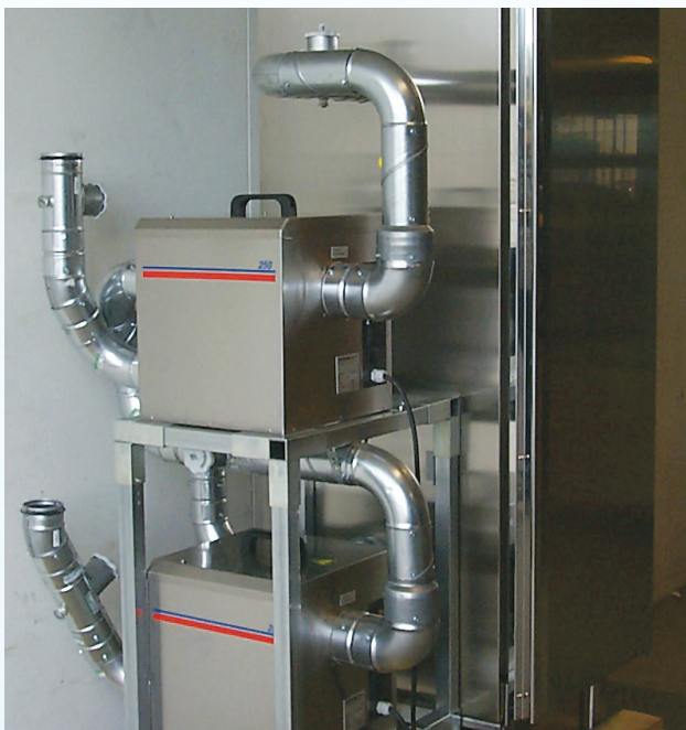
Электронная промышленность. Поддержание влажности 2% в установке.
