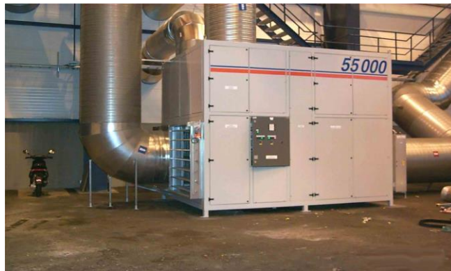
Склад металлических изделий. Осушитель DT55000 с воздушным потоком 55 000 м³/ч
