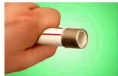
**4.** Вставьте фитинг в трубу до упора. При этом для облегчения монтажа следует применять специальную силиконовую смазку или воду.
