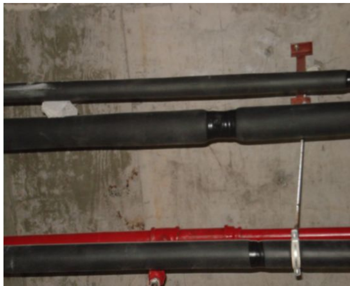
Стыки имеют тонкую теплоизоляцию
