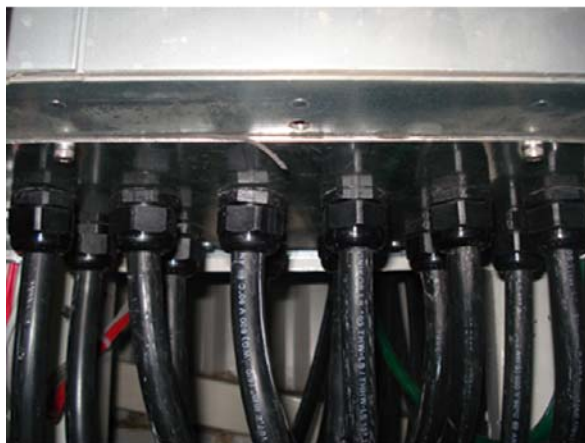
Рисунок 3.25: Пример правильной установки платы уплотнений.
