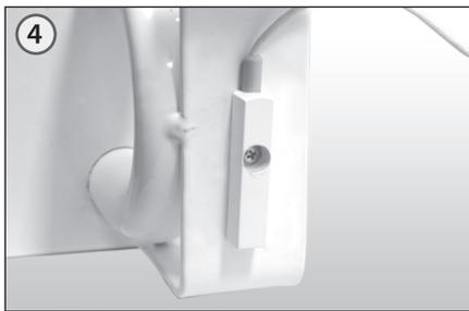
4. Монтаж выносного датчика для счетчика-распределителя тепла на конвекторы «Универсал» с приваренным кронштейном (*продолжение*)
