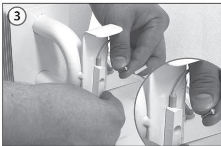
3. Закрепить выносной датчик на приваренном кронштейне при помощи винта М4 х 6. Провод выносного датчика должен быть направлен вверх.
