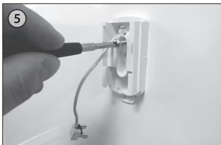
Зафиксировать платформу для крепления счетчика-распределителя тепла на фронтальной поверхности кожуха с помощью двух самонарезающих винтов.
