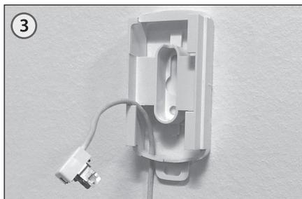
С помощью двух дюбелей и двух самонарезающих винтов закрепить платформу на стене.
