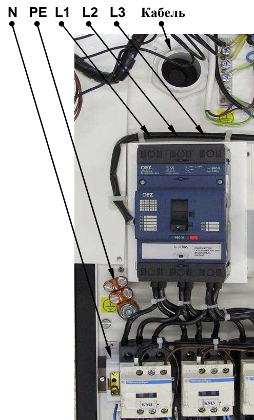
Рис. 21. Подключение входного кабеля котла «Daline PTE 22 – 60»
