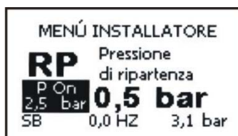
Rys. 17: Ustawienie ciśnienia wyzwalającego uruchomienie
