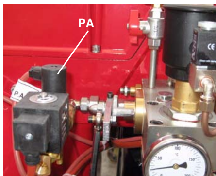
Рис. 28 - Реле давления сжатого воздуха для распыления топлива
