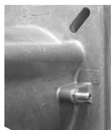
Штуцер для замера давления в камере сгорания
