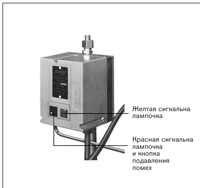
Рис. 4 – прибор для контроля на герметичность
